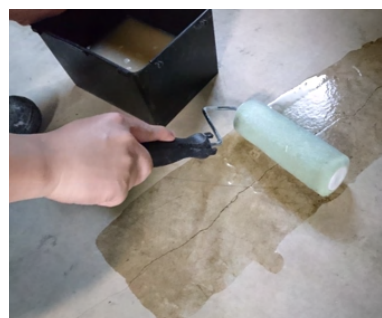
ローラー、ハケによる施工
