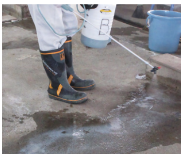
噴霧器による施工
